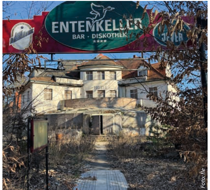
Der Eingangsbereich des Entenkellers mit provisorischen Türen
